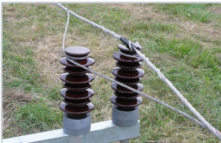
Mocowanie na obostrzeniu przewodu z wykorzystaniem uchwyty oplotowego bezpiecznego XOT.
