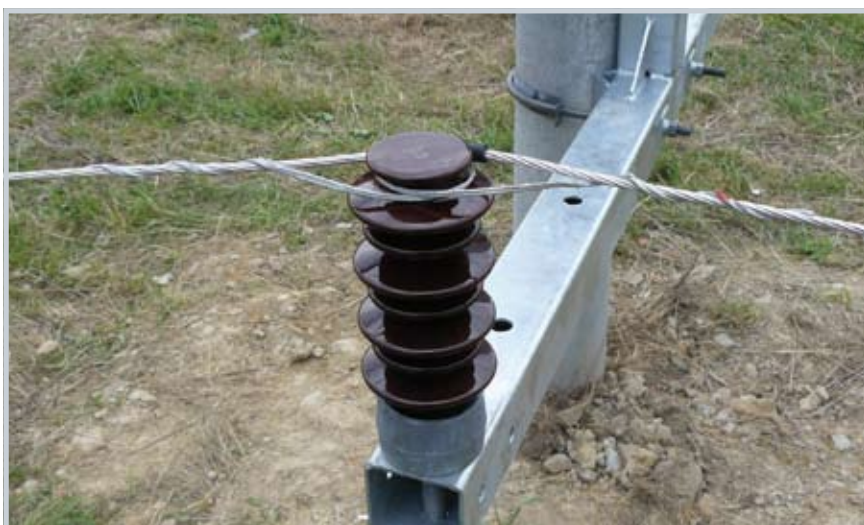
Zawieszenie przewodu na załamie linii SN uchwytem oplotowym narożnym AT.
