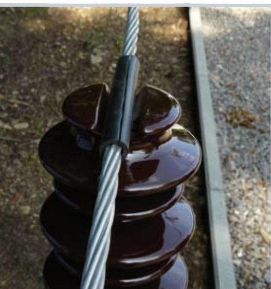
Nakładka neoprenowa uchwytu przelotowego chroniąca przewód oraz powierzchnię izolatora.
