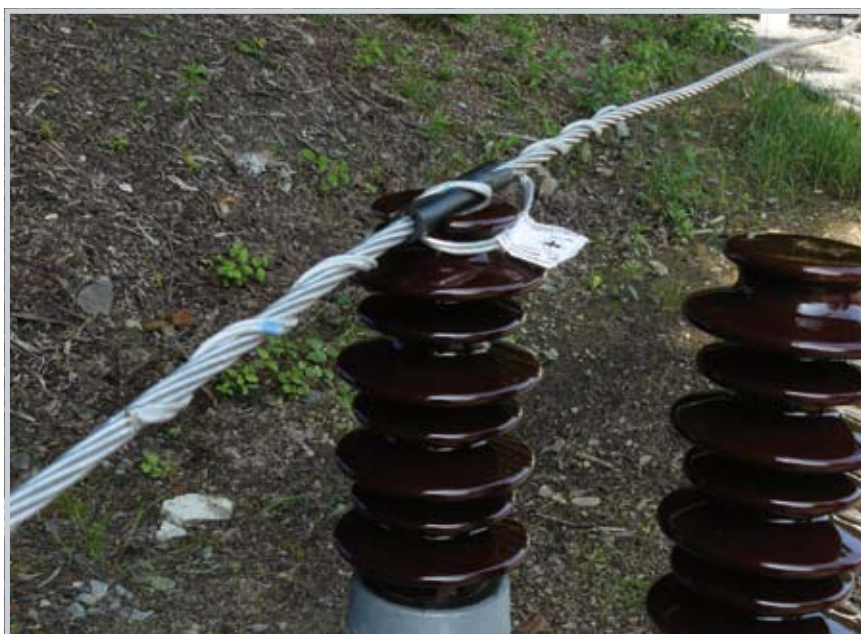
Mocowanie przewodu w linii SN przelotowe środkowe uchwytem oplotowym DT.
