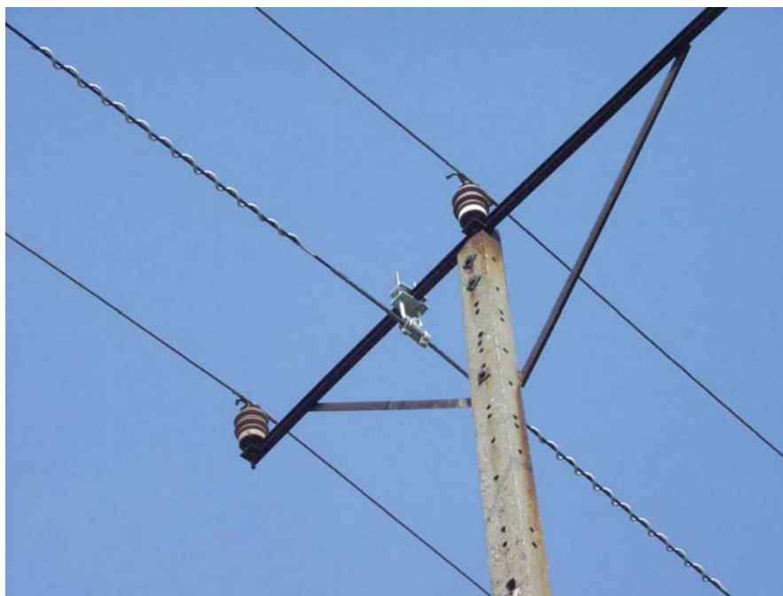
Rys. 5. Spiralne tłumiki drgań po obu stronach zawiesia przelotowego
