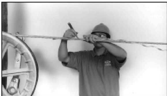
RYСУNEK 3 – WYKONYWANIE ZNACZNIKA NA PRZEWODZIE OZNACZAJĄCEGO POŁOŻENIE UCHWYTU PRZEWODZĄCEGO PRĄD
