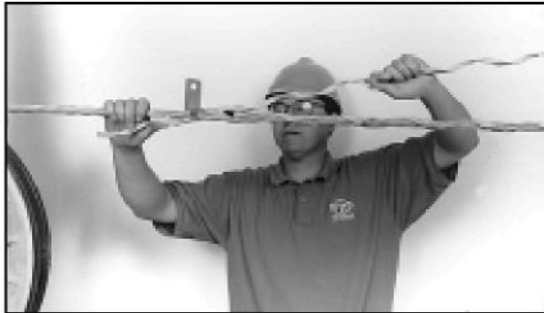
RYSUNEK 8 – POZYCJONOWANIE DRUGIEGO PODZESTAWU OPLOTU WZGLĘDEM UCHWYTU PRZEWODZĄCEGO PRĄD
