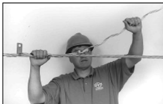
RYСУNEK 7 – NAKŁADANIE PIERWSZEGO PODZESTAWU POPRZECZ OWIJANIE GO WOKÓŁ PRZEWODU
