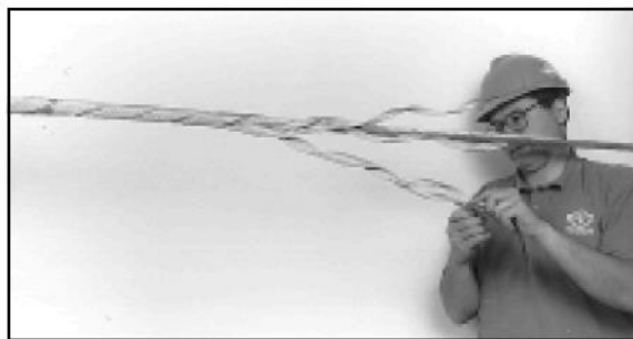
RYСУNEK 15 – ROZDZIELENIE KOŃCÓW W CELU UŁATWIENIA NAKŁADANIA
