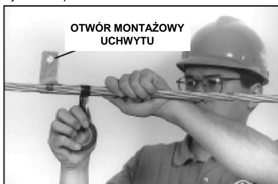
RYСУNEK 4 – POZYCJONOWANIE UCHWYTU PRZEWODZĄCEGO PRĄD I STOSOWANIE TAŚMY
