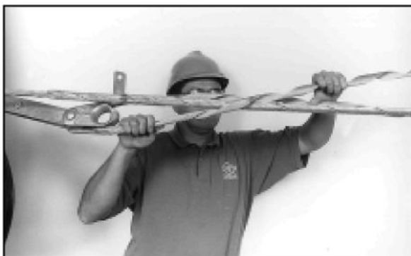
RYСУNEK 13 – DOPASOWANIE OZNACZENIA KRZYŻOWANIA NA UCHWYCIU ODCIĄGOWYM DO KOLOROWEGO ZNACZNIKA NA OPLOCIE OCHRONNYM SRR
